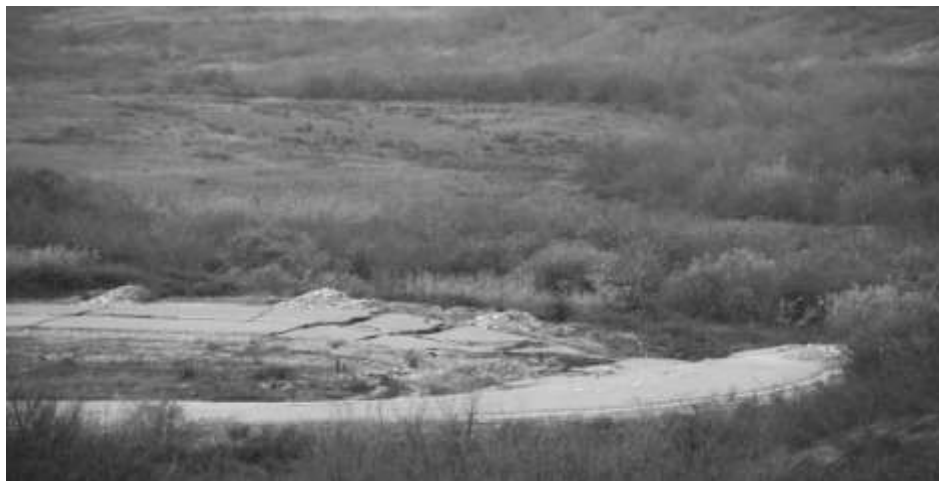
Şəkil 1. Sürüşmənin təsirindən dağılmış yol (Muğanlı-İsmayılı, 2012-ci il).
