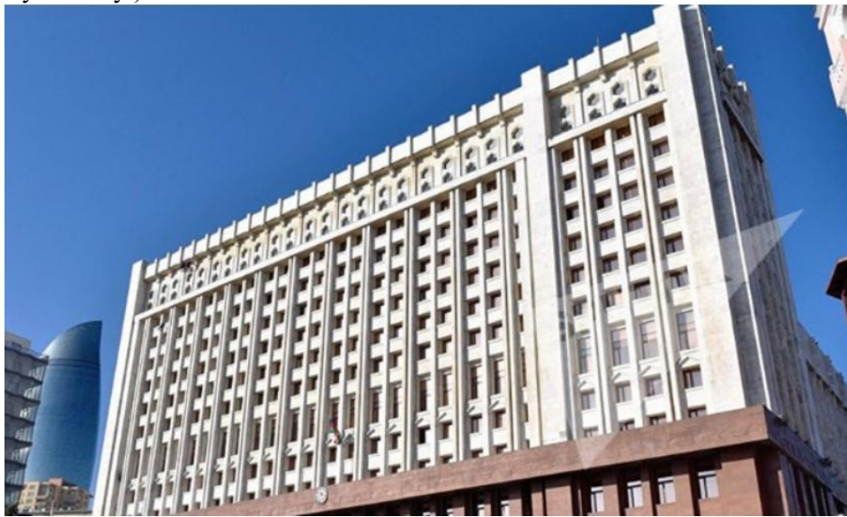
Şəkil 7. Mərkəzi Azərbaycan Kommunist Partiyası Komitəsi (indiki Prezident Aparatının binası)
