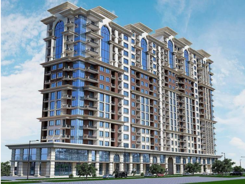
Şəkil 1. “Baku Nar Residence” kompleks tipli yaşayış binası. Bakı, (2021)
