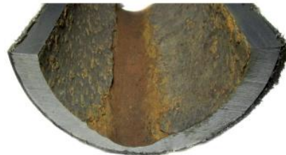
Şəkil 4. 894 sutka istismardan sonra \varnothing 114 \times 12 mm borunun metalının korroziya dağılması
