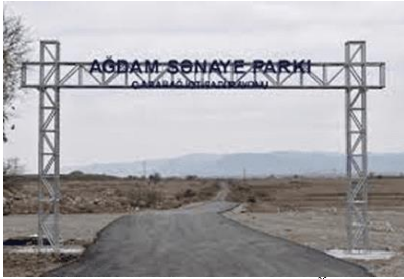
Şəkil 1. Ağdam Sənaye Parkı 26
