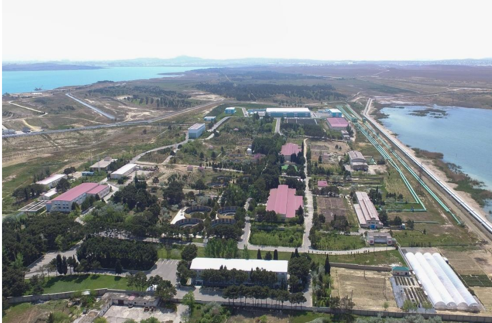
Şəkil 2. Ceyranbatan Sətəmizləyici Qurğular Kompleksi
