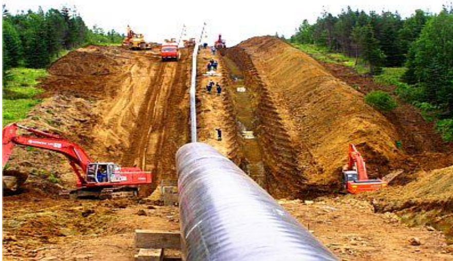
Şək.2 Qaz kəməri dəhlizində tikinti-quraşdırma işlərinin aparılması
