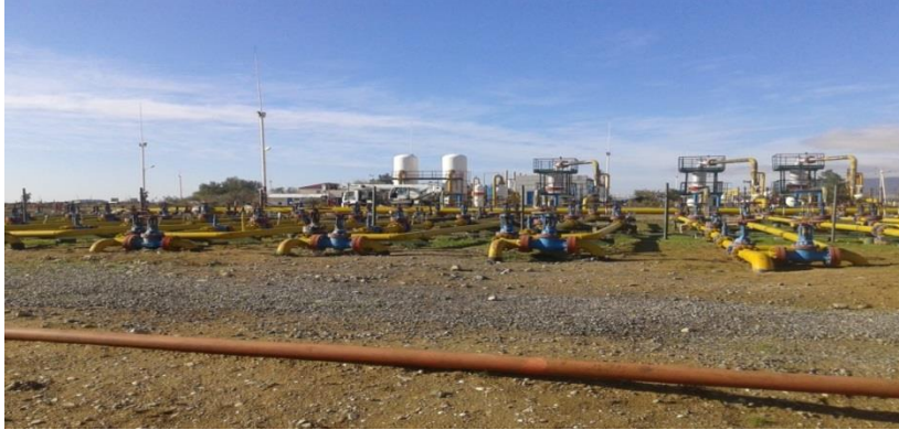
Şəkil.1. Qaradağ YQA-da köhnə qazpaylama məntəqəsində 5 quyuluq monifold sistemi
