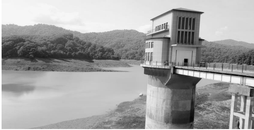
Şəkil 1. Xanbulançay su anbarının ümumi görünüşü
