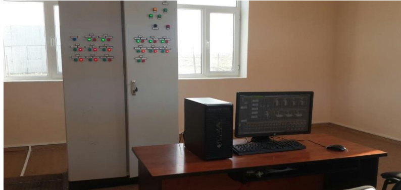
Şəkil.2. Azneft İB-nin "Qaz Anbarlarının İstisarı İdarəsinin Qaradağ YQA-da tətbiq olunmuş Avtomatik İdarəetmə Sistemi
